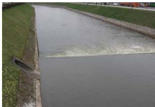
Slika 24: Regulisano korito trapeznog oblika i kaskade
