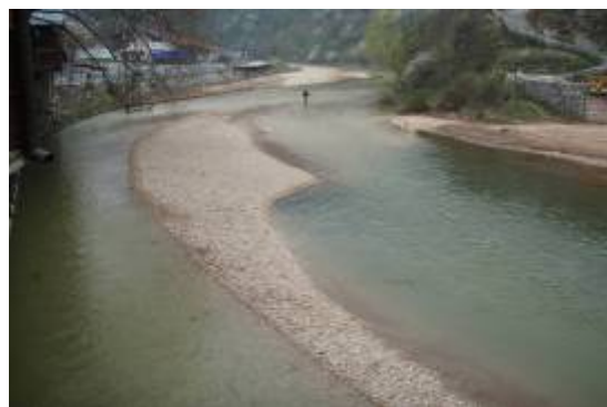
Slika 5: Miljacka Bentbaša-naslage nanosa uzvodno od pregrade
