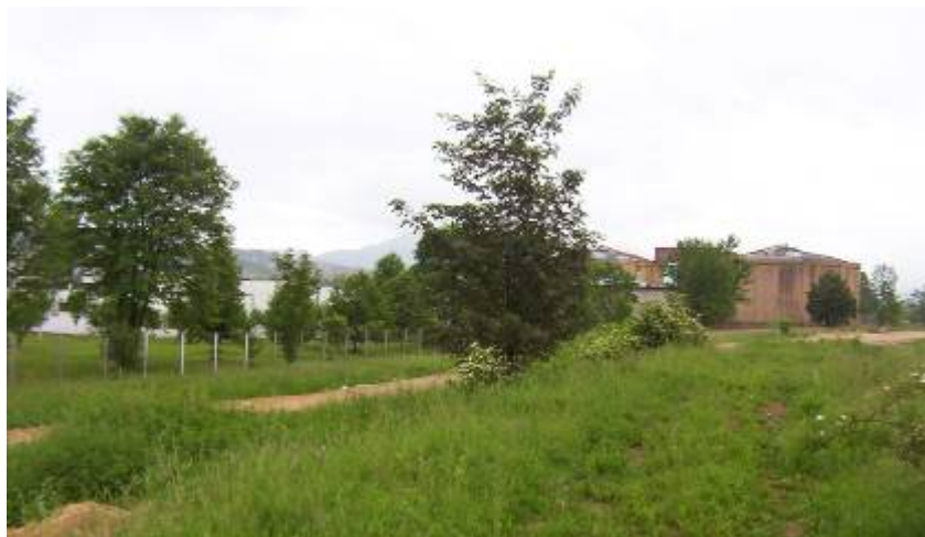
Slika 32: Uređaj za prečišćavanje otpadnih voda Butila
